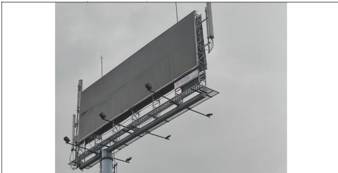
**Foto No. 2** – Vista del panel orientación Este – Oeste y de la estructura de la valla, en buenas condiciones y estable.
